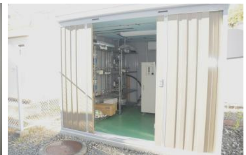
動物低酸素実験室の制御室
